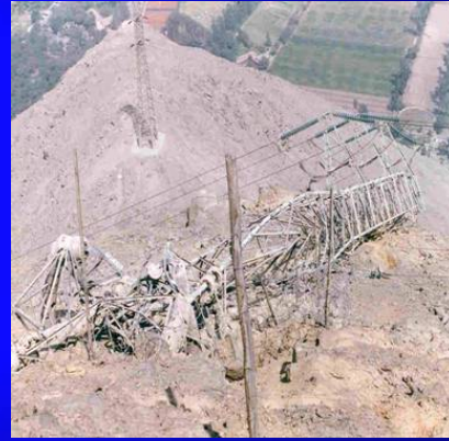
Infraestructura pública - ataques terroristas.
